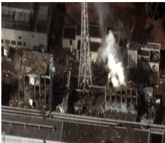
Havariertes Atomkraftwerk Fukushima. Foto: Digital Globe [CC BY-SA 3.0 ( https://creativecommons.org/licenses/by-sa/3.0/ )]
